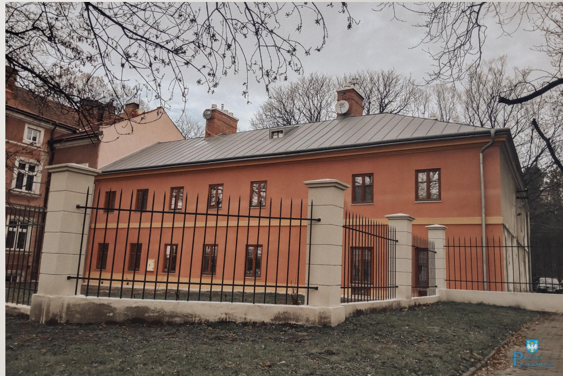
stan po konserwacji
