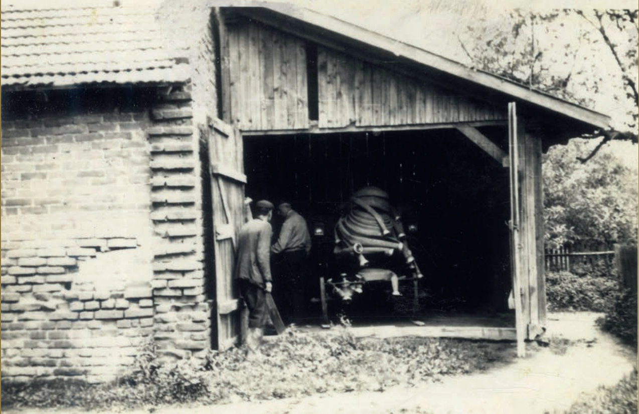
Drewniana remiza strażacka, 1. poł. XX w., OSP Ujezna, MP-PF-583
