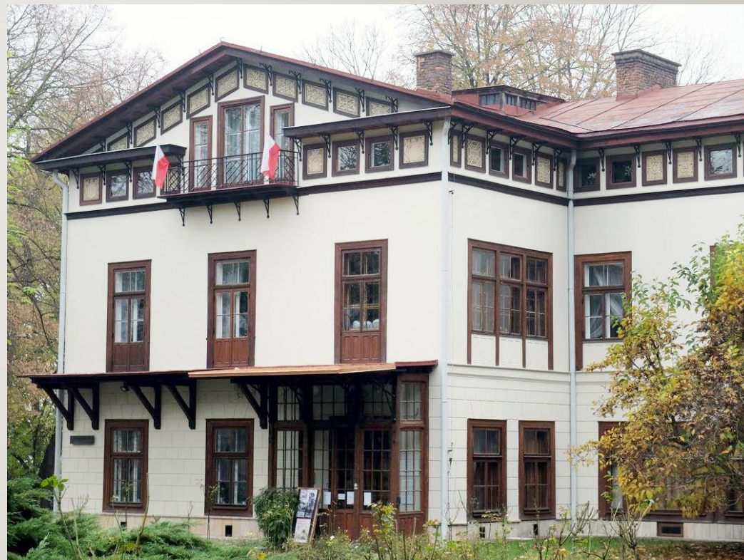
stan po konserwacji
